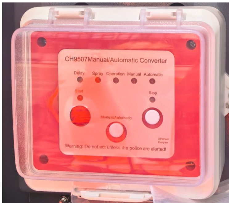
Abbildung 2-20-8: Handtaster für Notauslösung und Notstopp
