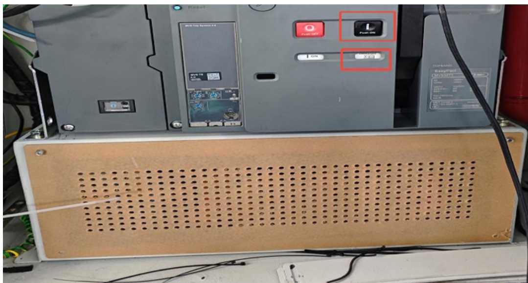
Abbildung 6-1-6: Offener Leistungsschalter mit ungespanntem Federspeicher
